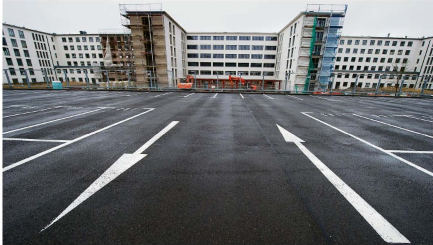
Ferienanlage Prora: Früher „Kraft durch Freude“, heute Denkmalschutz und Ferienwohnungen
