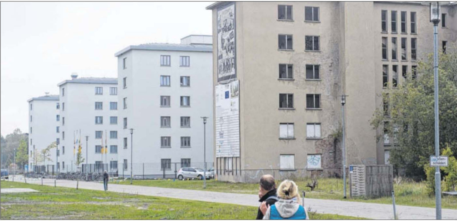
Blick auf Block V, in dessen saniertem Teil seit 2011 die Jugendherberge ihr Domizil hat.
