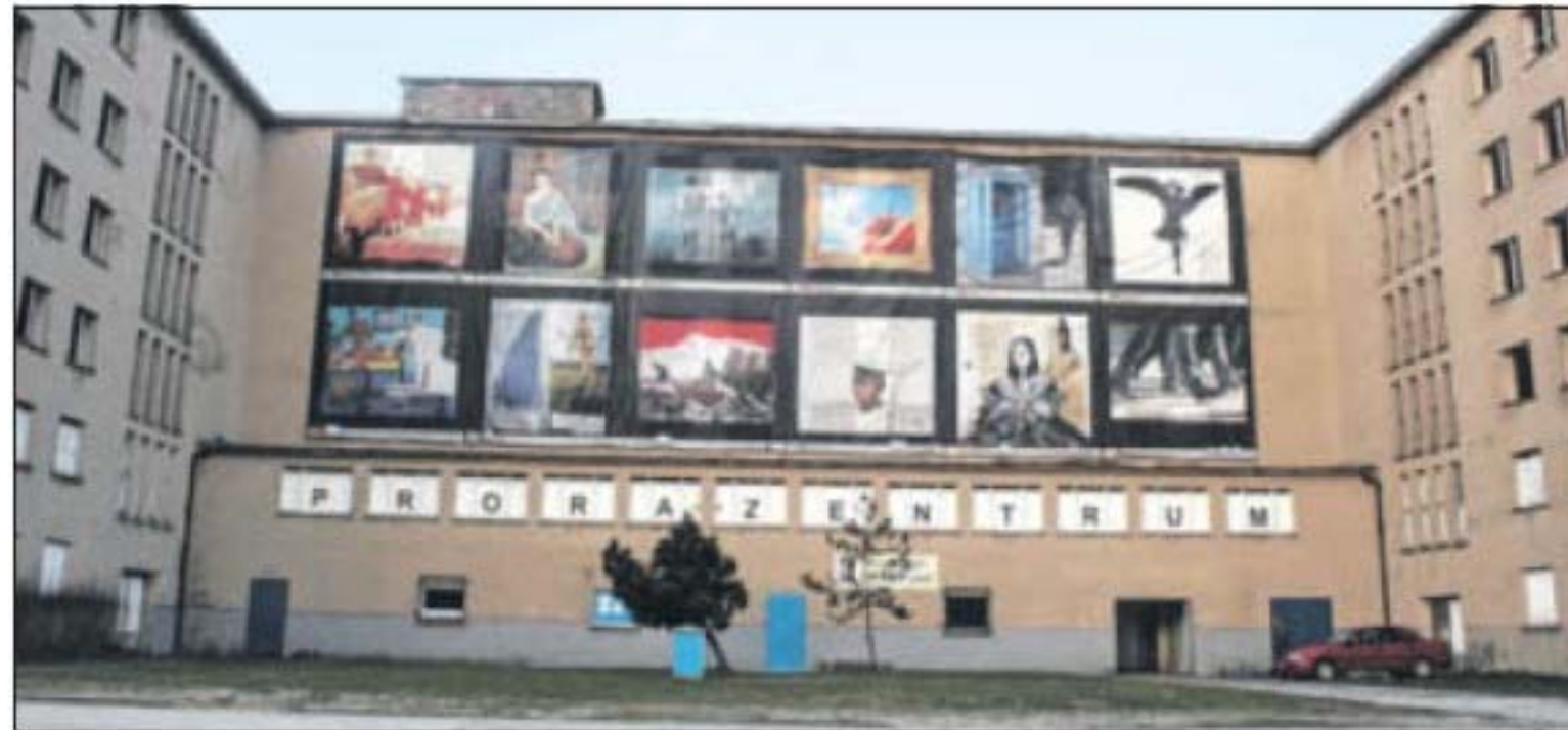
Der Block V ist der letzte Teil der Anlage, der sich noch in öffentlicher Hand befindet. Auch er soll verkauft werden.
