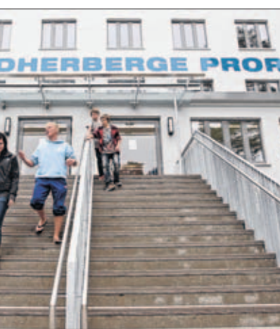
Eingangsbereich der Vier-Sterne-Herberge in Prora. In der ersten Saison ist das Haus komplett ausgebucht.
