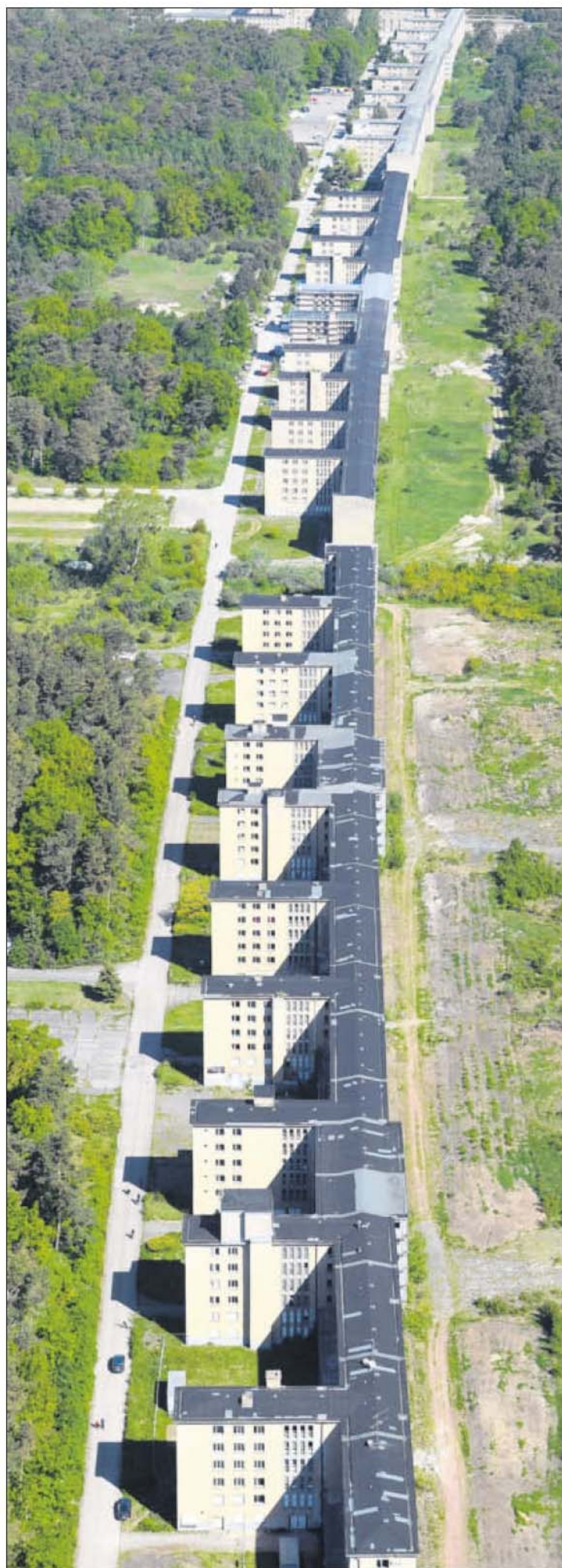
Blick auf die ehemalige Nazi-Immobilie in Prora. Dort haben Berliner Investoren die ersten Ferienwohnungen verkauft. Fotos: Stefan Sauer
