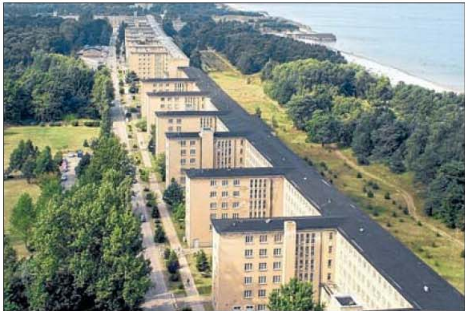
Fast fünf Kilometer lang sind die Blöcke des alten Kraft-durch-Freude-Bades Prora. Sie wurden von 1936 bis 1939 von den Nazis gebaut. Foto: Archiv
