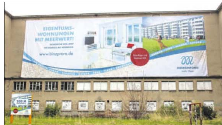
„Meersinfonie“ nennen die Berliner Investoren ihr Projekt in Block II in Prora, in dem Eigentumswohnungen entstehen. Fotos (2): Gerit Herold
