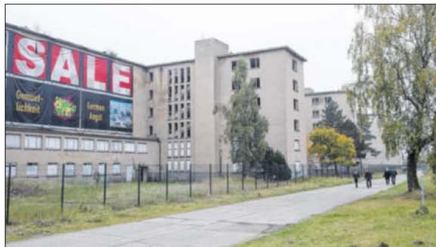
In den noch unsanierten Teil des großen Gebäudes sollen nach dem Verkauf vor allem Wohnungen entstehen.
