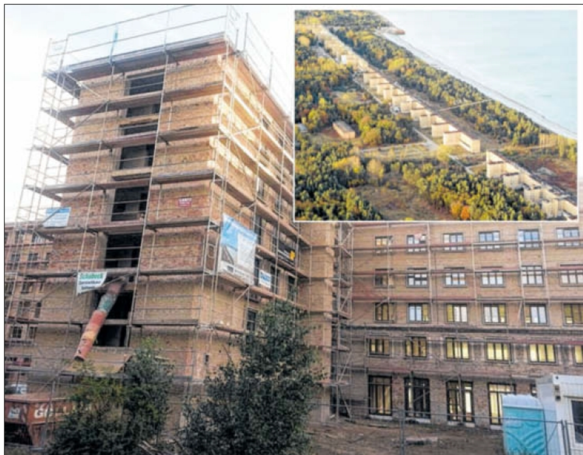
Im Aufgang 6 des Hauses 2 werden aktuell 30 Mietwohnungen errichtet, die zwischen 40 und 100 Quadratmeter groß sind. In der Luftbildaufnahme können Interessenten die Lage der Mietwohnungen erkennen.
